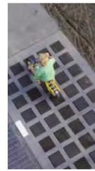
La SolaRoad di Amsterdam, prima pista ciclabile solare al mondo, ha superato le aspettative producendo in un anno più di 9.800 Kwh e coprendo il fabbisogno elettrico di tre abitazioni. Lunga 70 metri, è ricoperta da uno strato di vetro temperato, sotto cui si trovano celle solari in silicio cristallino racchiuse in moduli di calcestruzzo. La pista, che genera energia anche nei giorni nuvolosi, è stata percorsa da circa 200 mila ciclisti.
